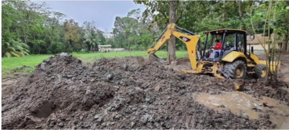
Panóramica de los trabajos de limpieza en Quiriguá.
