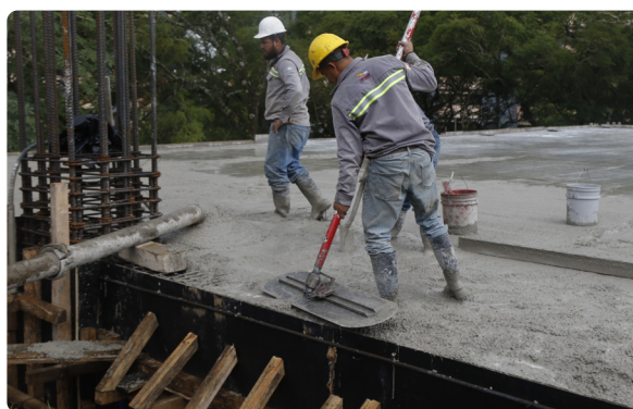
Edificio de la Danza
