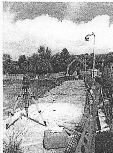
Fotografías Numero 18, y 19; Se observa el proceso de trazo de niveles mediante estación total, dentro del polígono de ejecución del proyecto.
