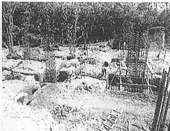
Fotografías Numero 26, y 27; Se observa el proceso de implementación de armadura de hierro para zapatas, así como la fundición de concreto de las mismas.
