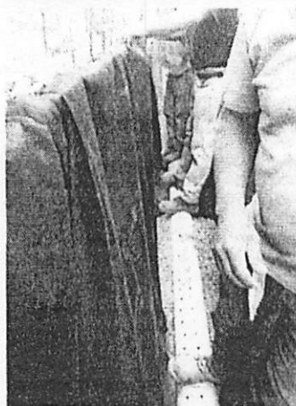
Fotografías Numero 57 y 58; Se observa el proceso de implementación de geotextil, tubería de PVC corrugado con perforación para captación de aguas y piedrín.
