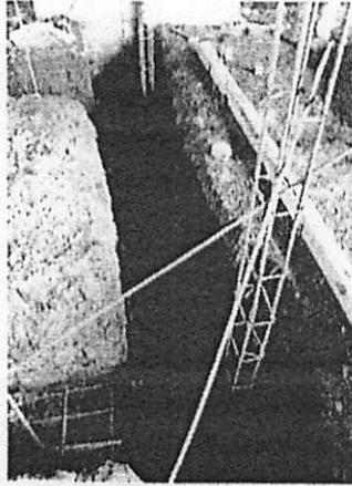
Fotografías Numero 65, y 66; Se observa el proceso de implementación de armadura de hierro para cimiento, así como el proceso de fundición de concreto.
