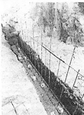
Fotografías Numero 43, y 44; Se observa el proceso de implementación de armadura de hierro para cimiento, así como el proceso de fundición de concreto.
