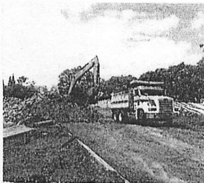
Fotografías Numero 3, y 4; Se observa el proceso de retiro de ripio y/o material sobrante por medio de retroexcavadoras y camiones de volteo.
