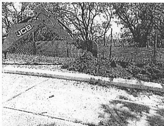
Fotografía Numero 7; Se observa la retroexcavadora realizando el retiro de baldosas de concreto.
