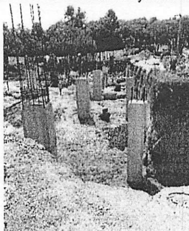
Fotografía Numero 51; Se observa el proceso de implementación de armadura de hierro para columna, así como el proceso de encofrado y fundición de concreto, a su vez se observan columnas ya fundidas y completas.
