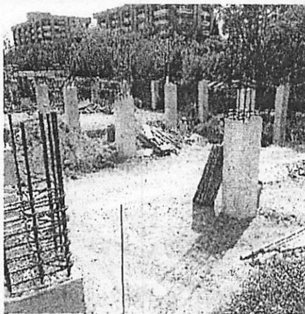
Fotografía Numero 53; Se observa el proceso de implementación de armadura de hierro para columna, así como el proceso de encofrado y fundición de concreto, a su vez se observan columnas ya fundidas y completas.
