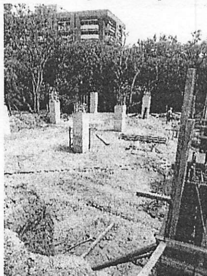
Fotografías Numero 24, y 25; Se observa el proceso movimiento de tierras con maquinaria industrial vertiendo el material selecto ara cubrir cimentación.
