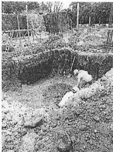
Fotografías Numero 22, y 23; Se observa el proceso movimiento de tierras para excavación del área que ocuparan las zapatas y los elementos estructurales.
