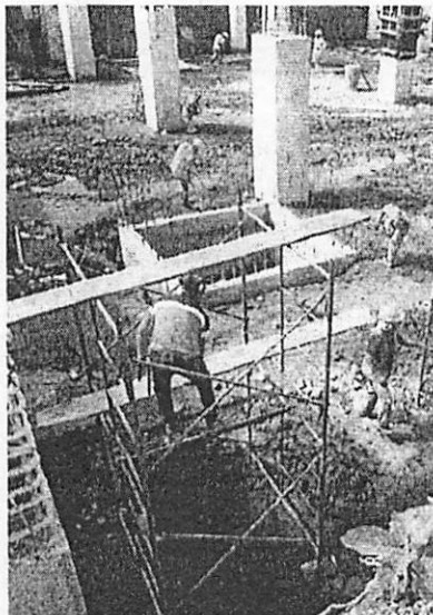
Fotografías Numero 45, y 46; Se observa el proceso de levantado de muro de contención en área de elevador, relleno y limpieza de la misma.
