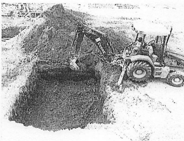
Fotografías Numero 22, y 23; Se observa el proceso movimiento de tierras para excavación del área que ocuparan las zapatas y los elementos estructurales.
