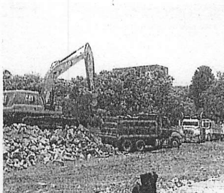
Fotografías Numero 3, y 4; Se observa el proceso de retiro de ripio y/o material sobrante por medio de retroexcavadoras y camiones de volteo.
