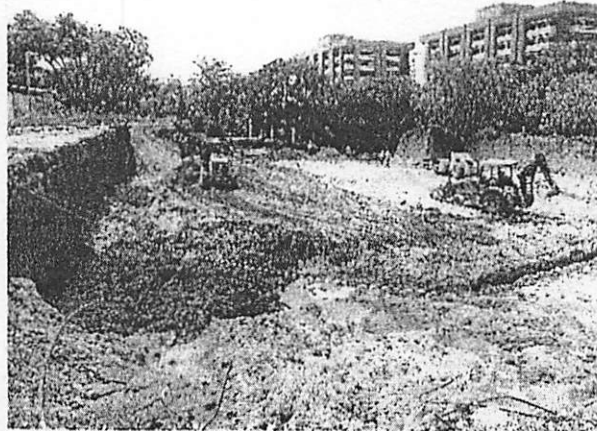
Fotografías Numero 20, y 21; Se observa el proceso de mejoramiento de suelo con la aplicación de mezcla de cemento tipo suelo cemento, y compactación mediante maquinaria industrial.
