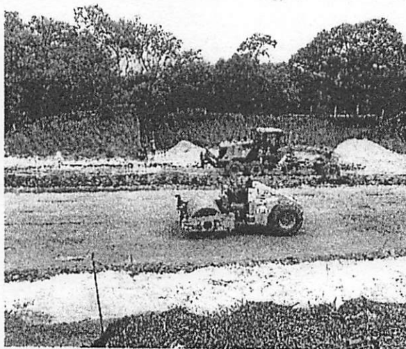
Fotografías Numero 20, y 21; Se observa el proceso de mejoramiento de suelo con la aplicación de mezcla de cemento tipo suelo cemento, y compactación mediante maquinaria industrial.
